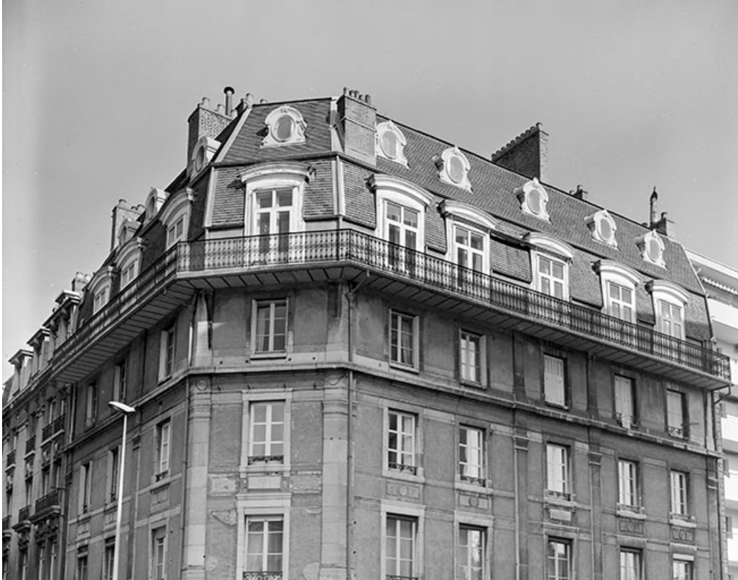
Vue générale des étages supérieurs.
