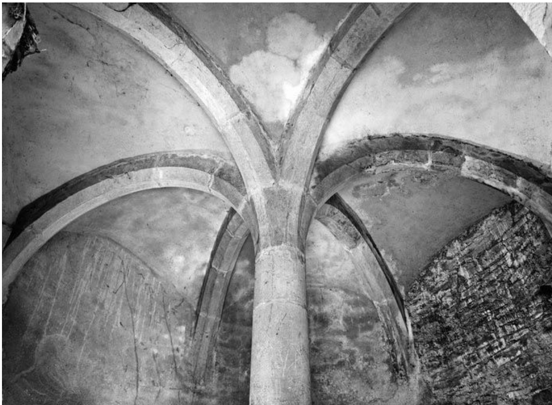
Tour Blondeau, casemate inférieure, détail : voûtement
