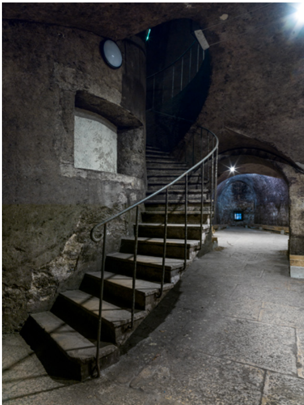
Caves, rez-de-chaussée : le monte-charge avec l'escalier tournant.
