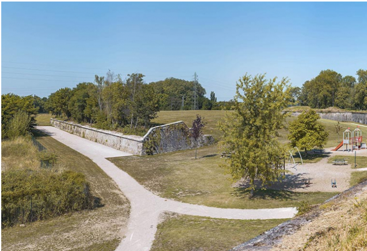
Face est de l'ouvrage.
