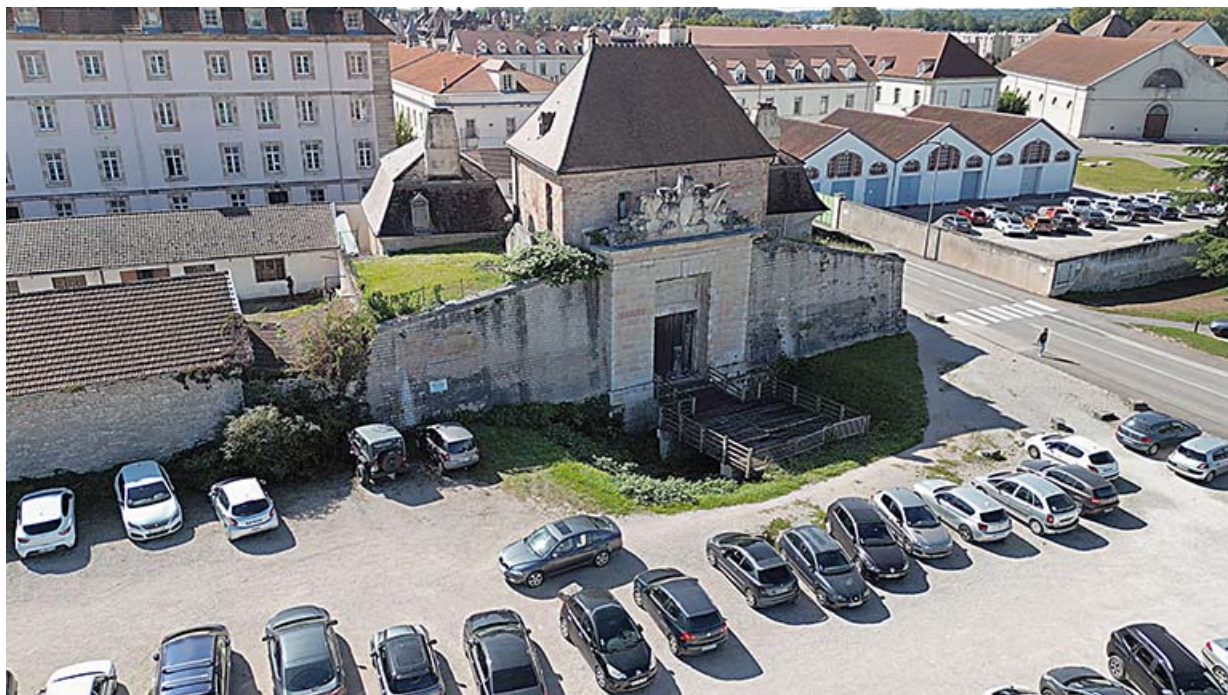
Vue aérienne de la porte.
