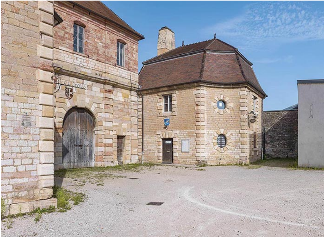
L'entrée cochère et un des pavillons.
