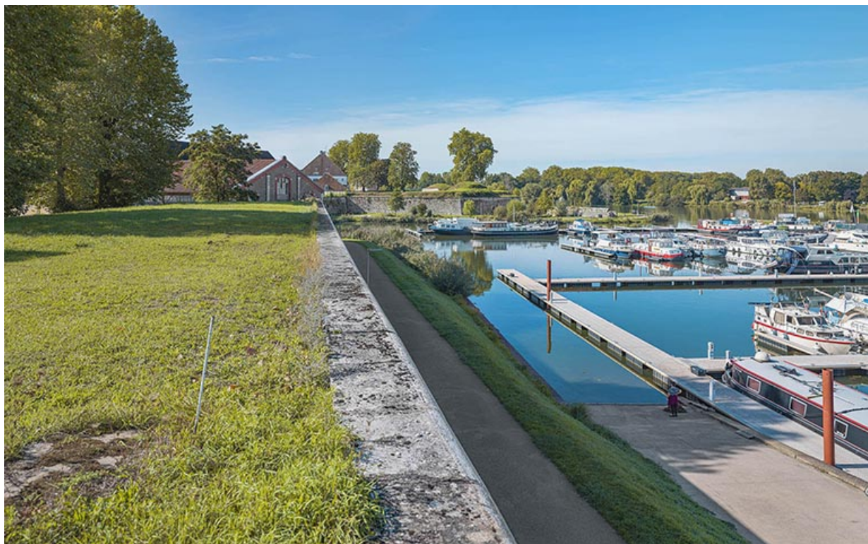
Terre-plein, parapet (face ouest).
