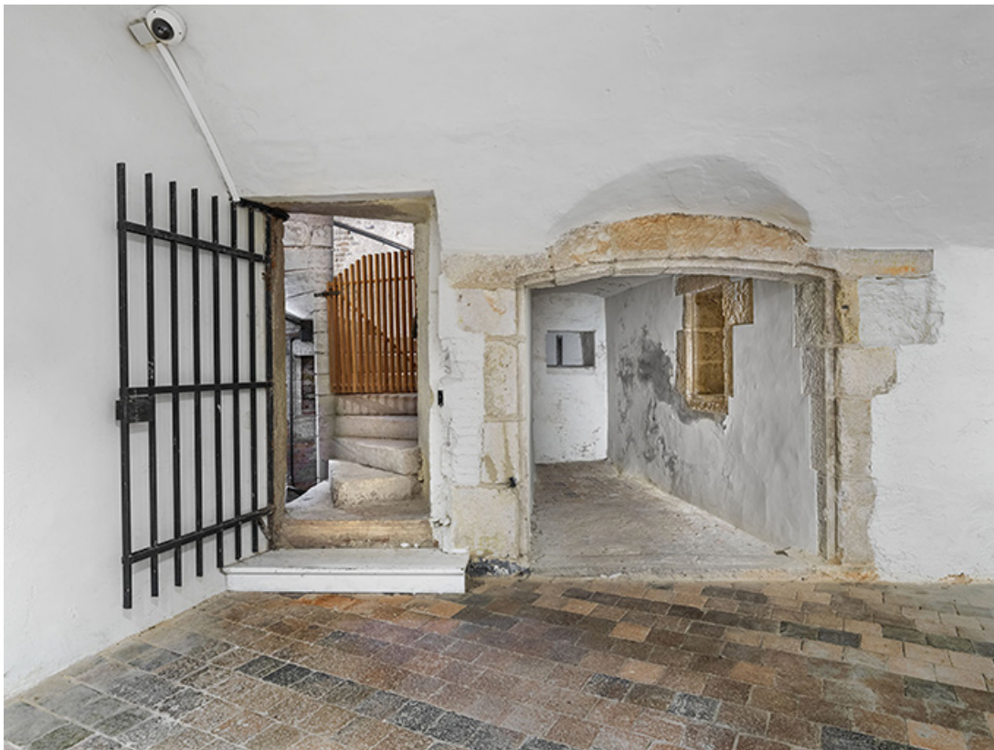
Tour Notre-Dame : porte d'accès au premier niveau.
