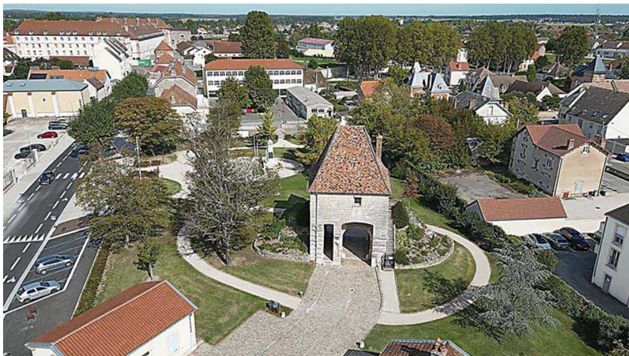
Vue aérienne de la porte.
