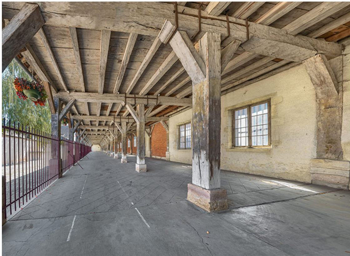
La charpente du hangar.
