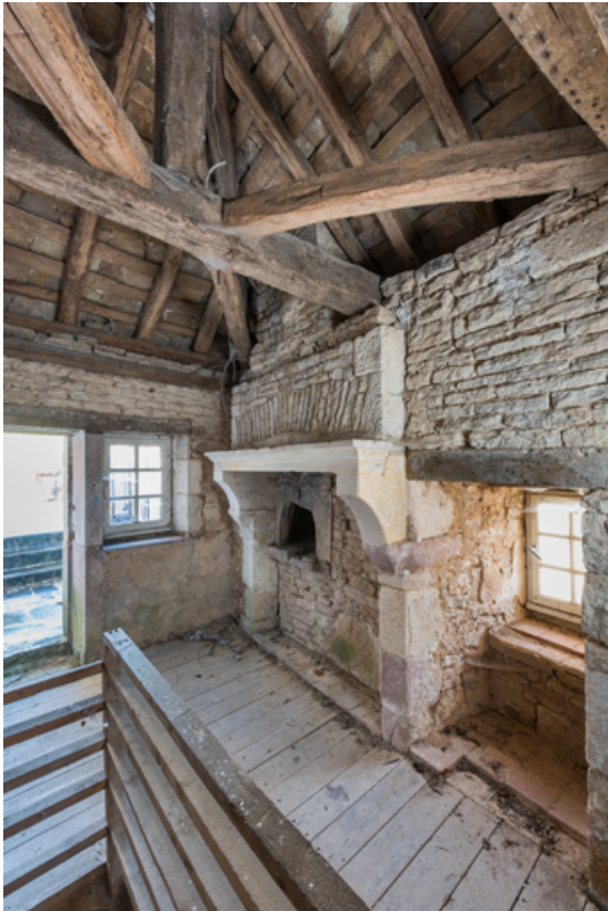
Vue intérieure de la cheminée.
