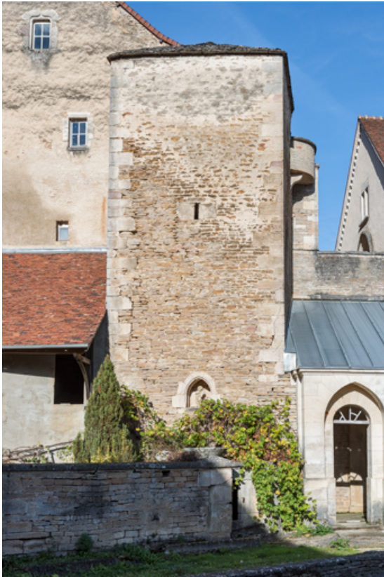
Vue de la façade nord-ouest.
