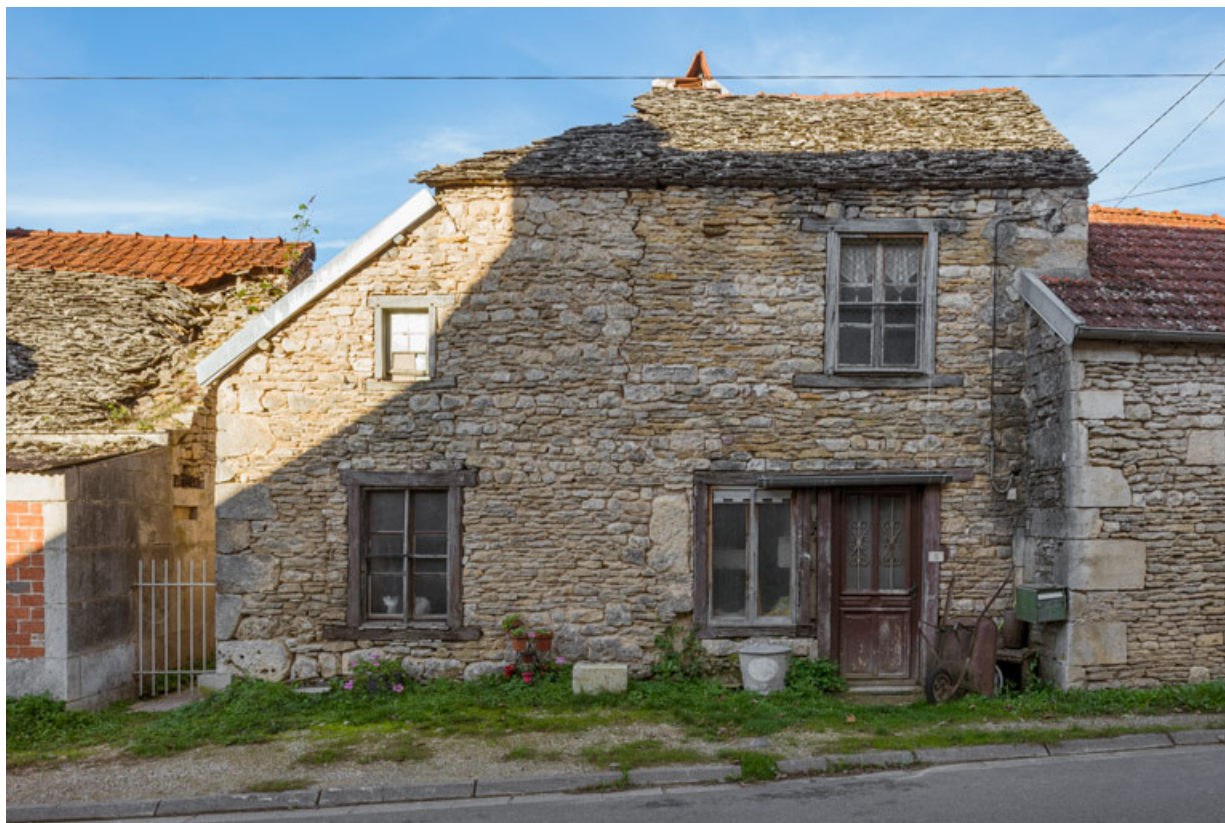
Vue de la façade sud.
