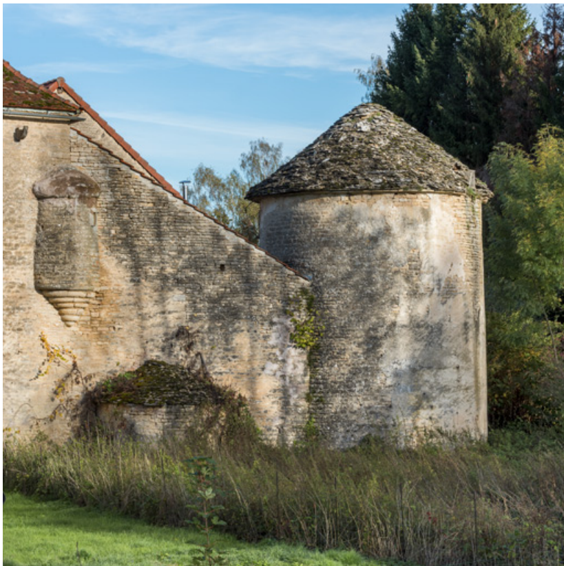
Vue d'ensemble depuis le sud.
