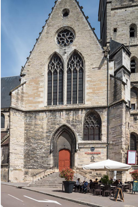
Façade sud : extrémité du transept.
