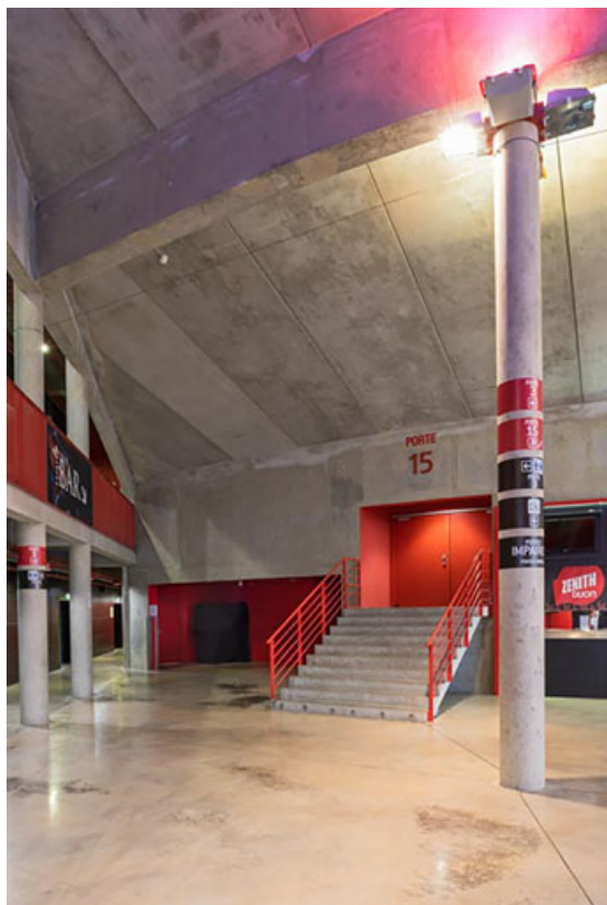
Vestibule : dessous des gradins et porte 15.
