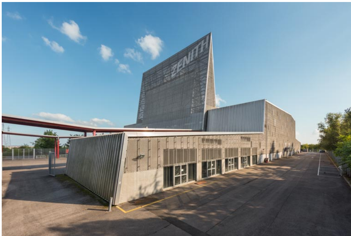
Façade latérale droite, de trois quarts gauche.
