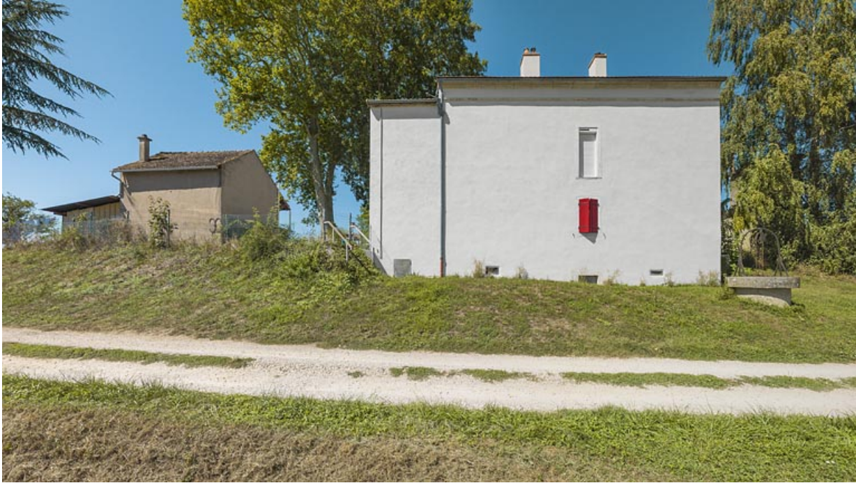
La maison éclusière : face arrière.
