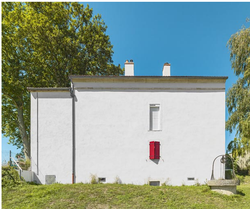
La maison éclusière : face arrière.
