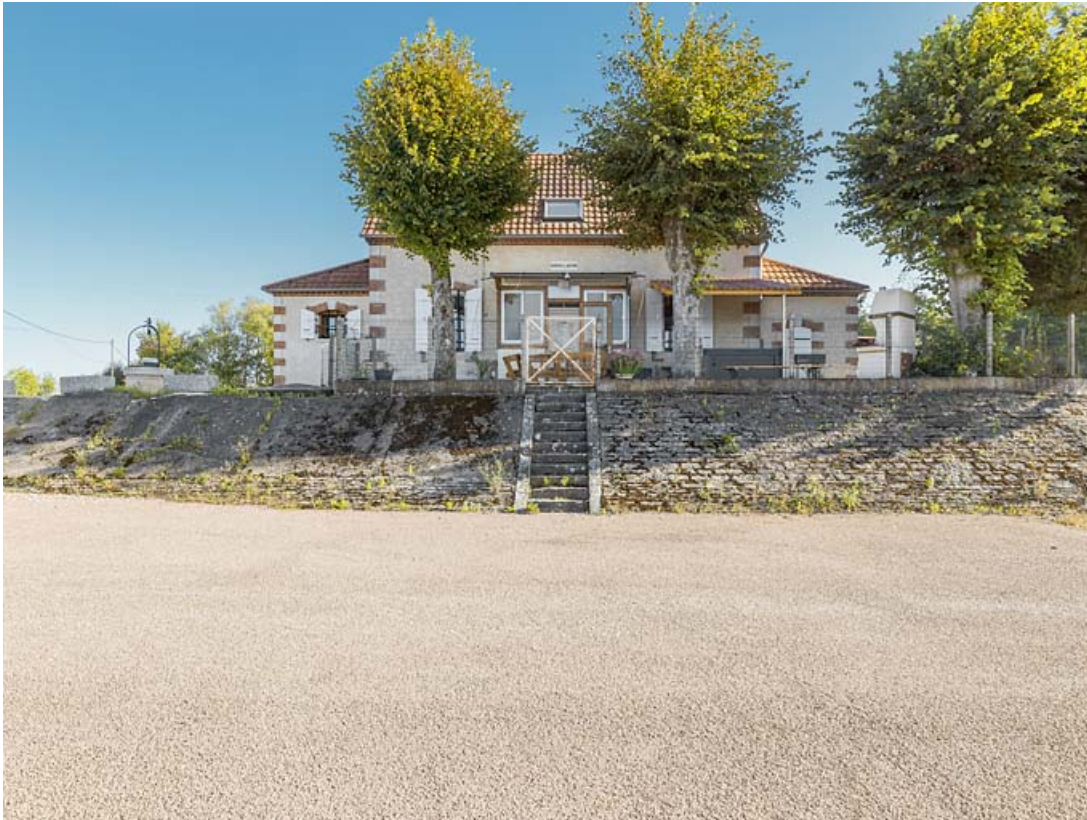
Vue d'ensemble de la maison du barragiste.
