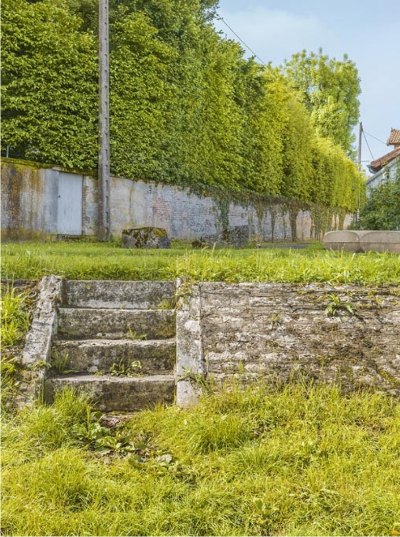
Deuxième escalier de la digue.
