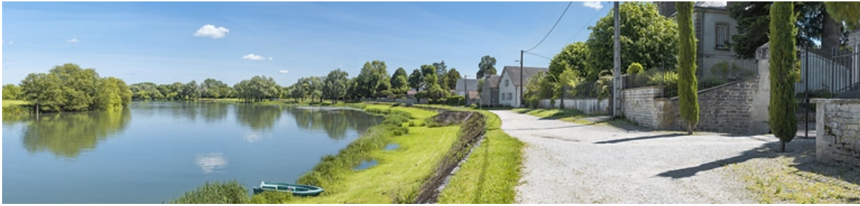
Vue d'ensemble de la digue, prise d'aval.
