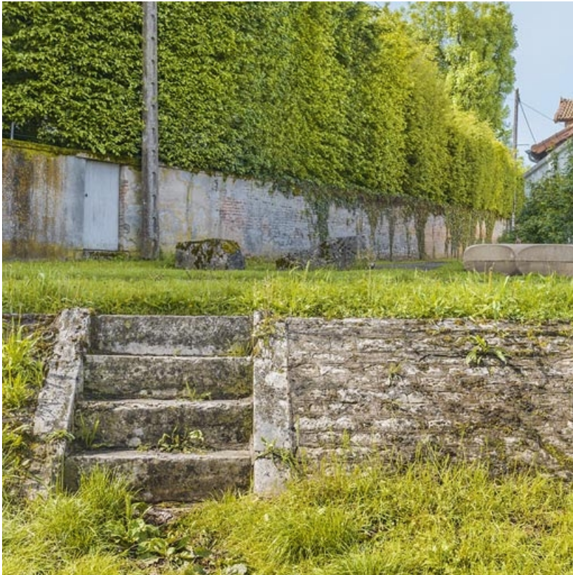
Deuxième escalier de la digue.
