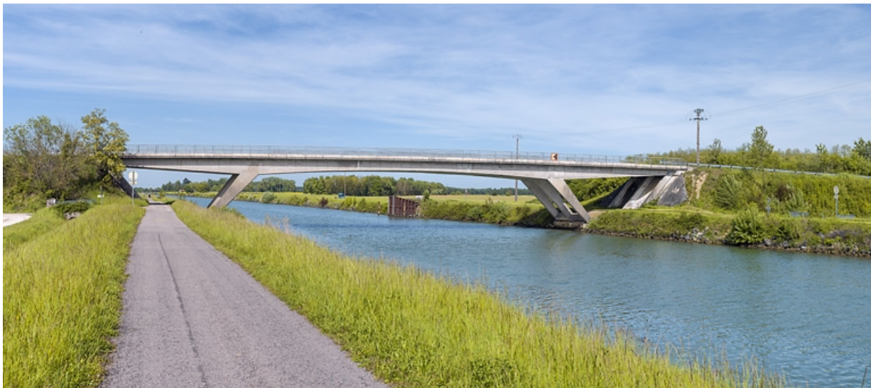
Vue d'ensemble d'amont, rive gauche.
