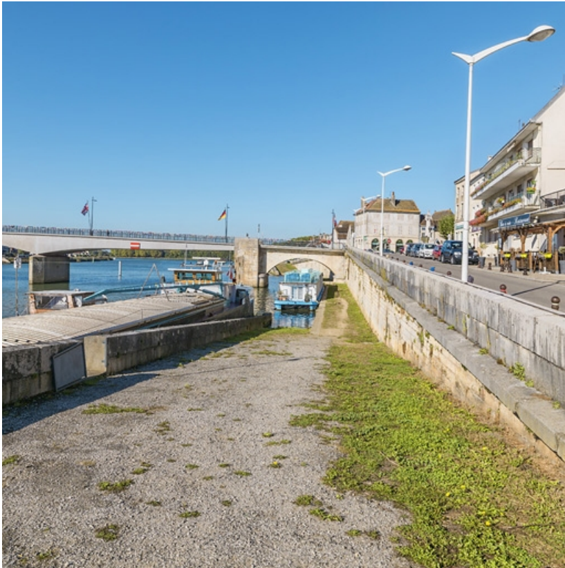
Arche maçonnée du pont, rive droite.
