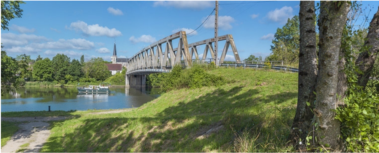
Vue d'ensemble, rive gauche.
