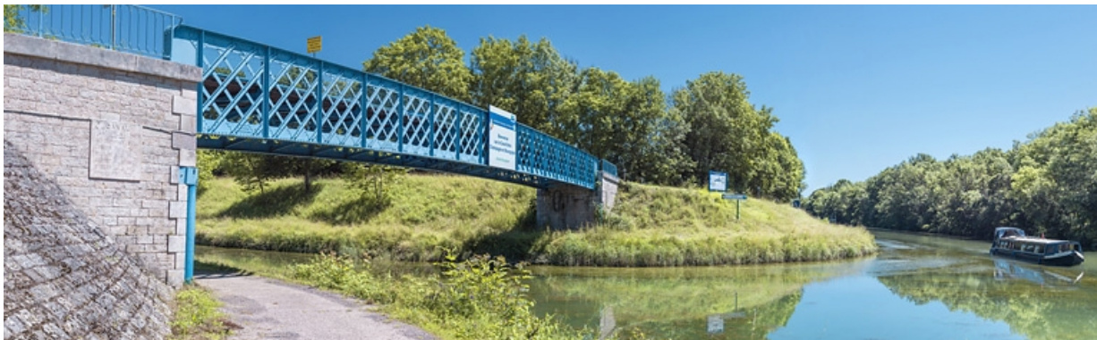
Vue d'ensemble. A droite, la dérivation d'Heuilley.
