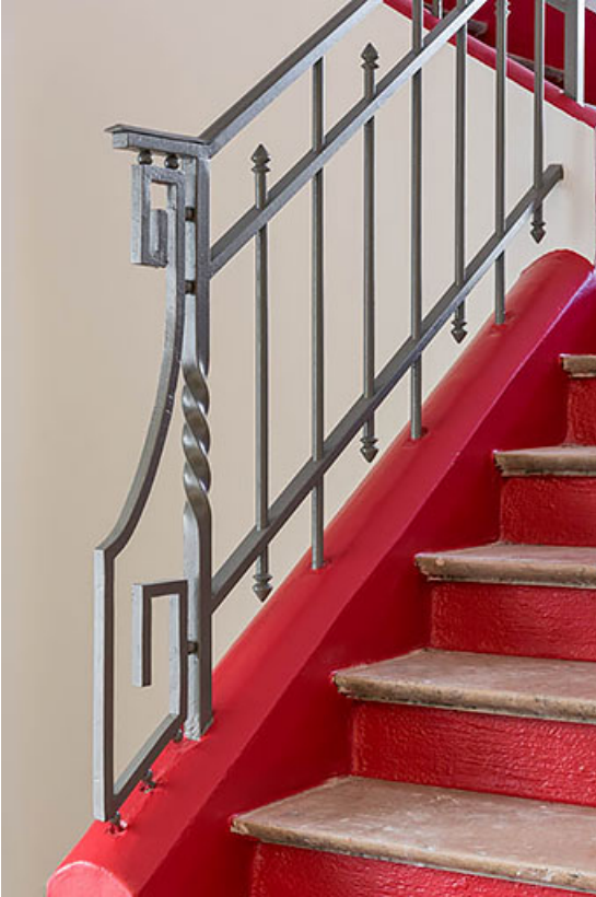
Vestibule : grille de l'escalier.
