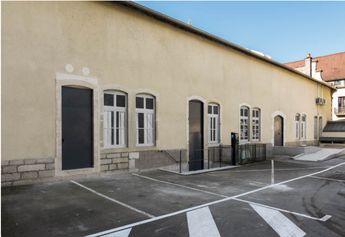
Façade latérale gauche, de trois quarts.
