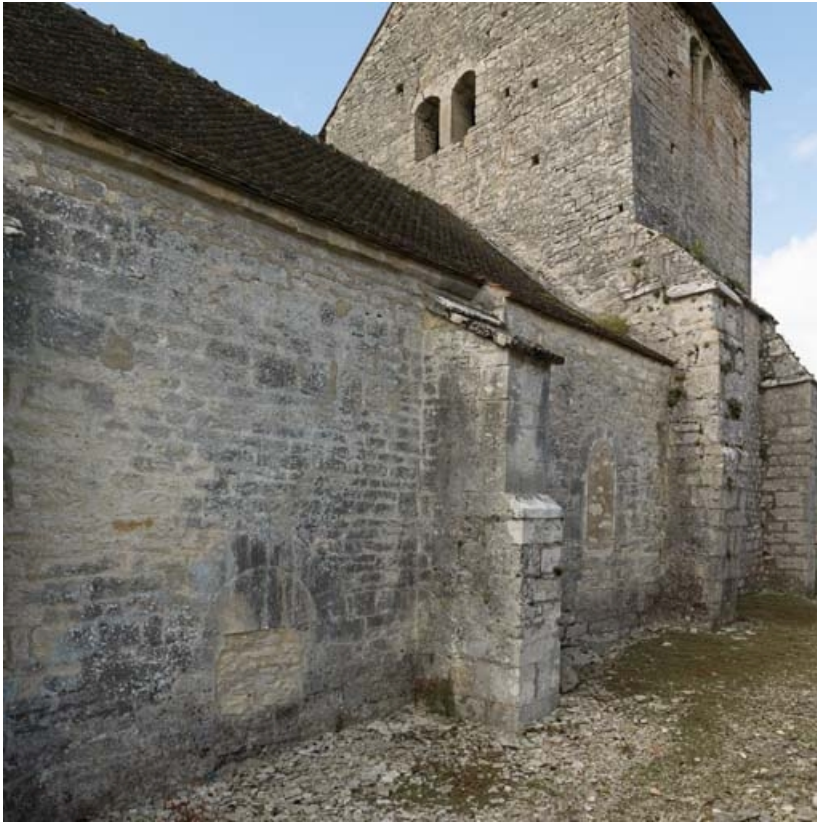
Détail des baies bouchées de l'élévation nord.
