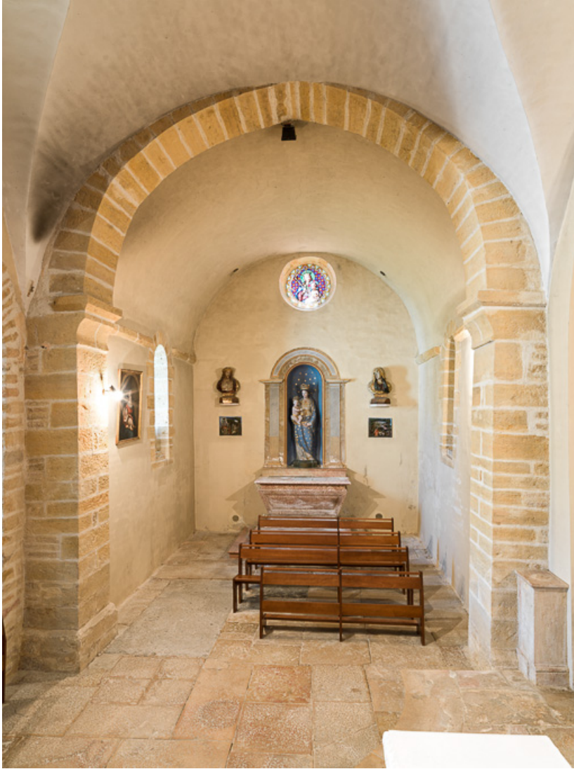
Vue du bras nord du transept.
