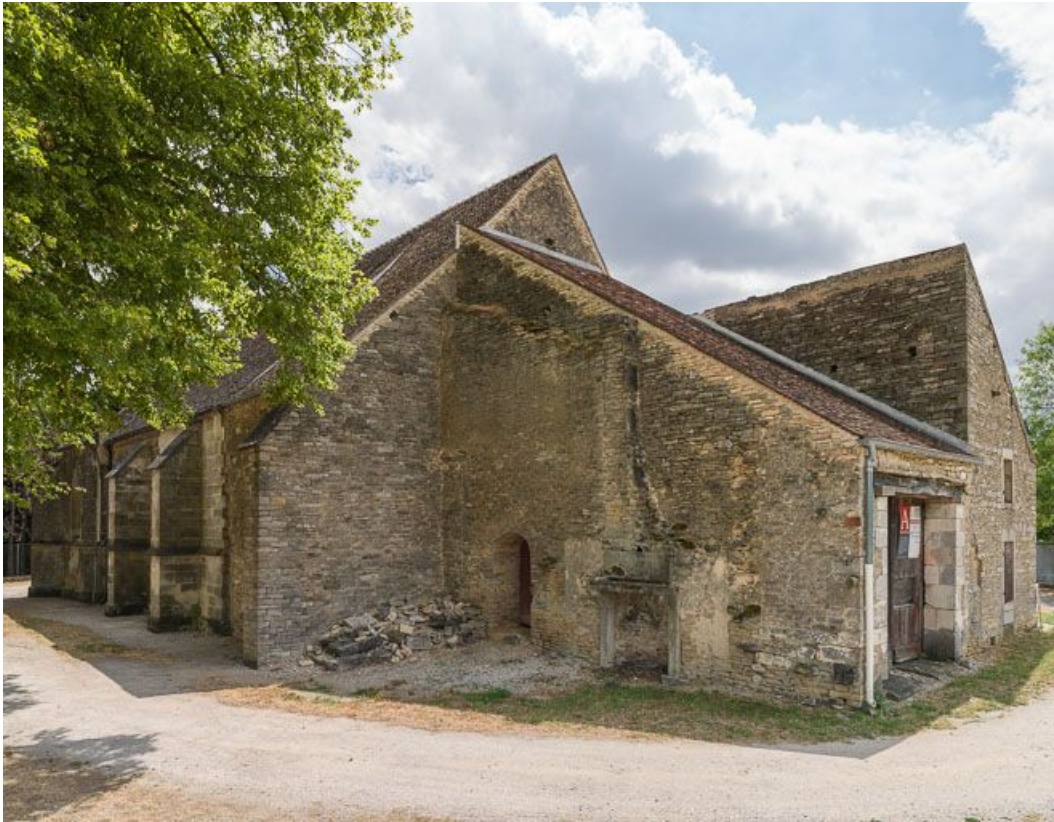
Vue de l'angle nord-ouest.
