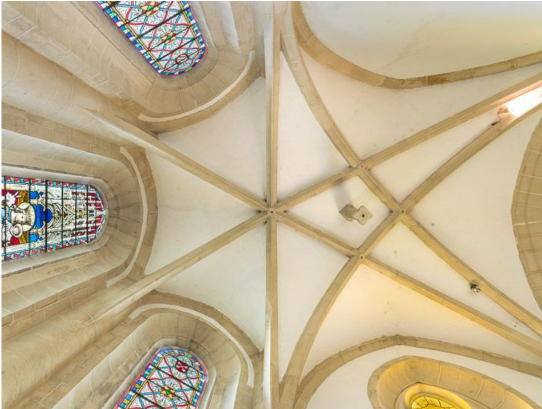
Vue de la voûte du chœur : détail.
