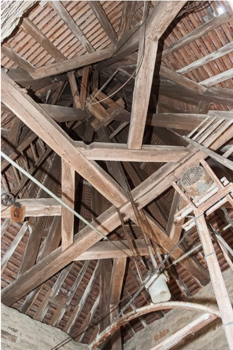
Charpente de la flèche du clocher.
