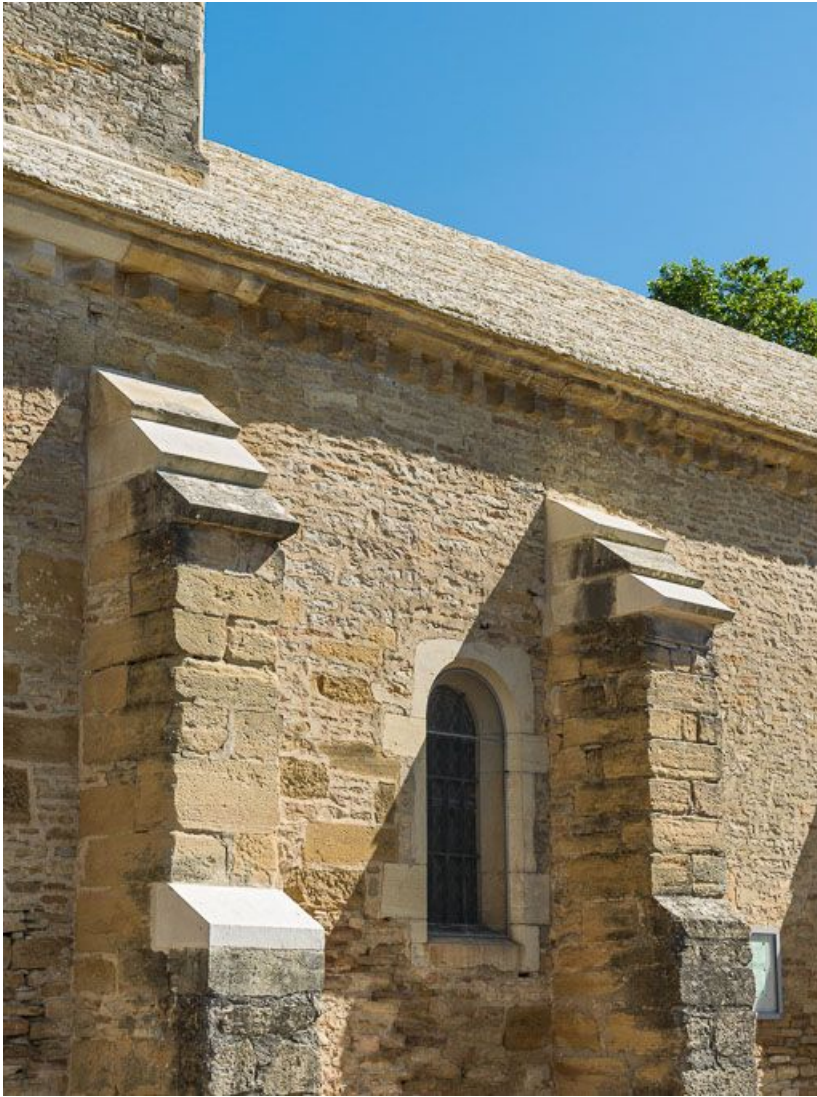
Élévation sud-ouest, détail de la travée.
