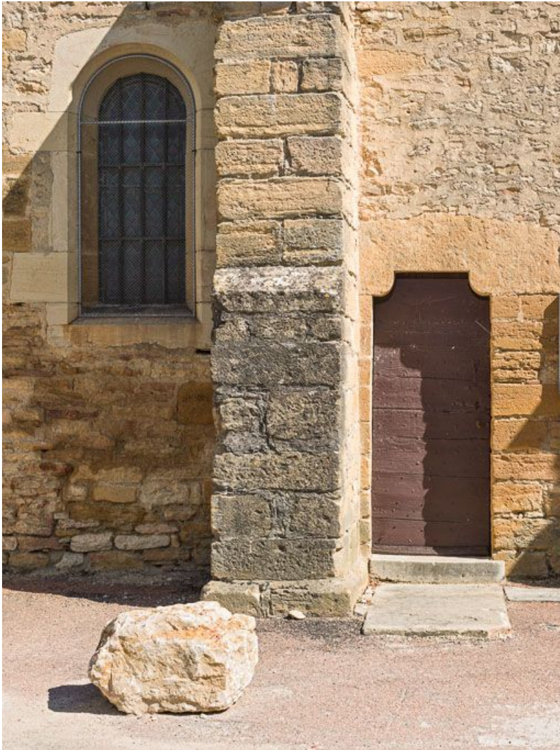
Élévation sud-ouest, détail de la porte latérale.
