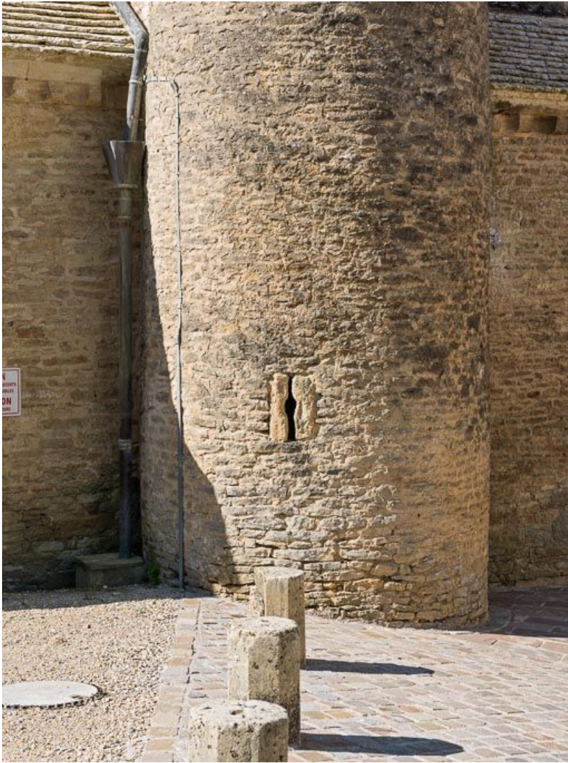
Tourelle d'escalier : détail du jour en archère.
