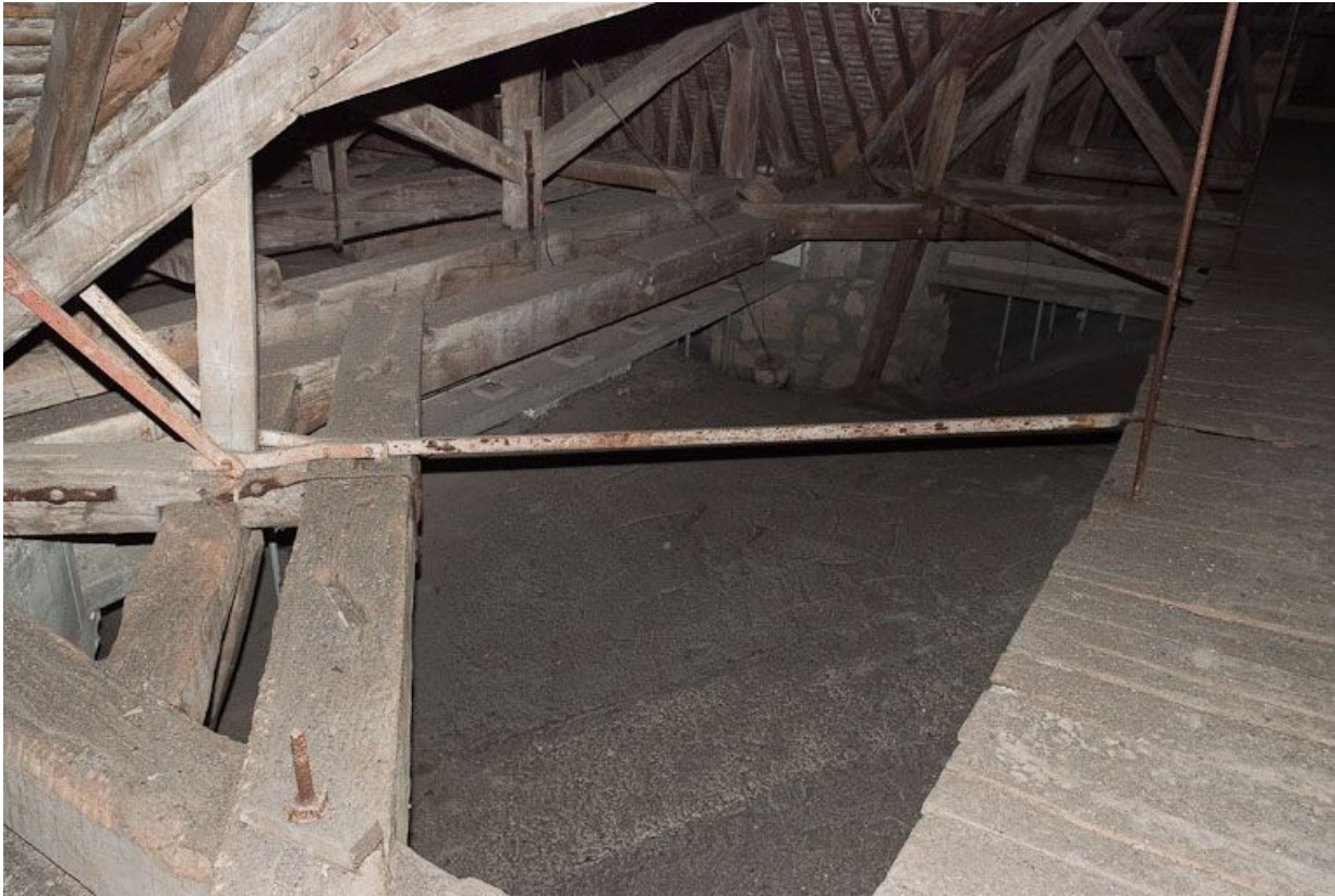
Comble du bras gauche du transept.
