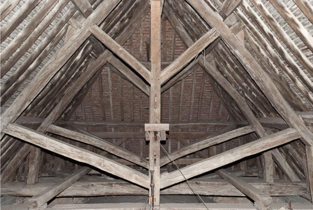
Charpente de la croisée du transept.
