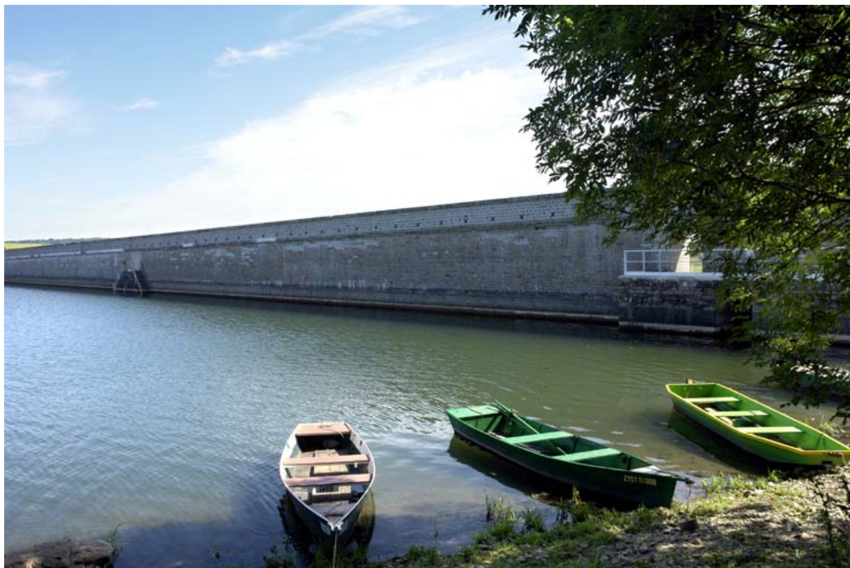
Vue d'ensemble du barrage, face réservoir.
