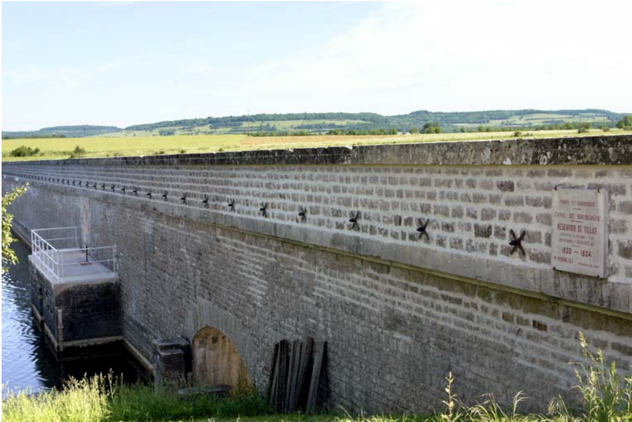
Le barrage, face réservoir.
