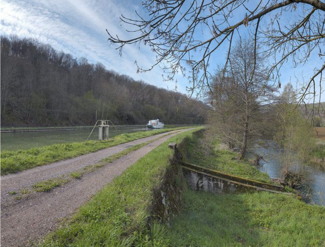
Le déversoir vu du chemin de halage.
