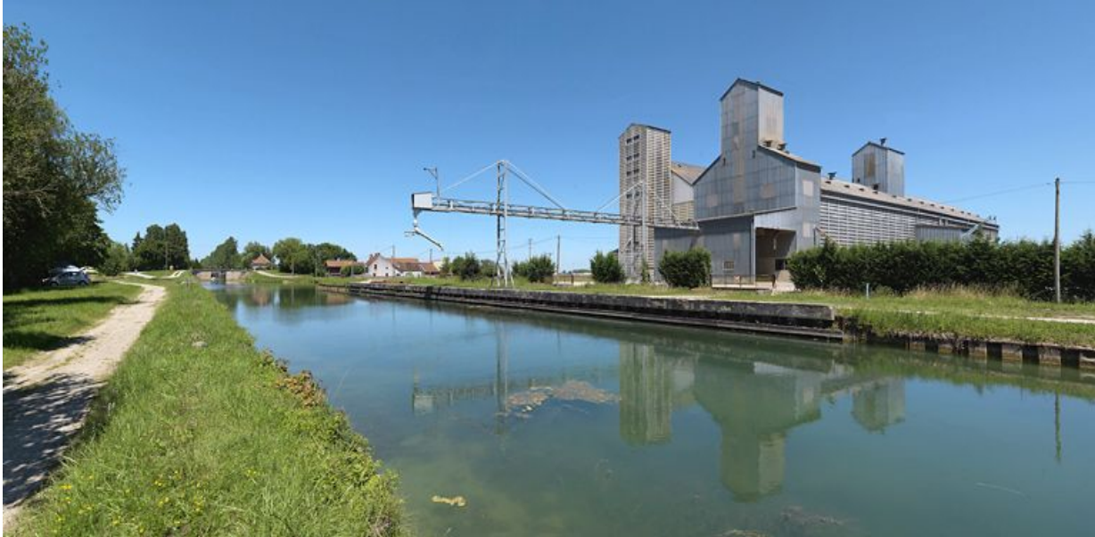
Silos à Longecourt-en-Plaine.
