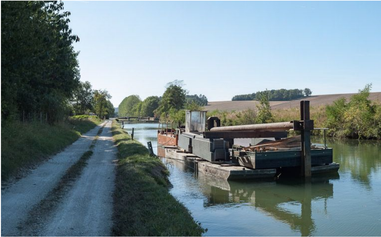
Barge de travaux sur palplanches à Ancy-le-Franc.
