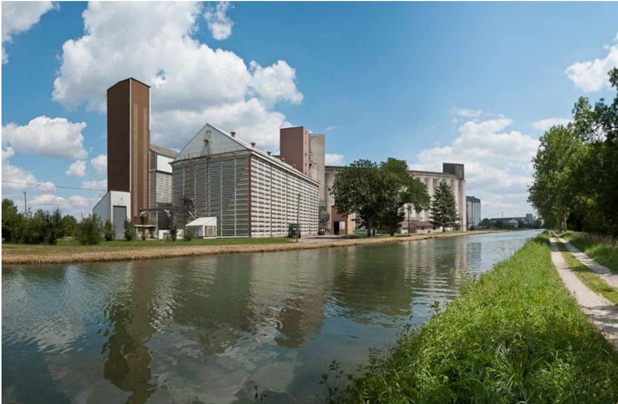
Vue des silos à Pacy-sur-Armançon.
