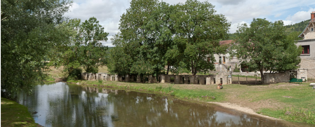
Vue du mur dit "évacuateur de crue".
