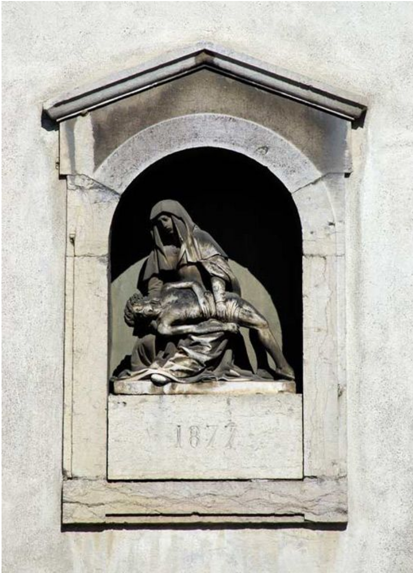
Niche de la façade rue des Petites-Casernes.
