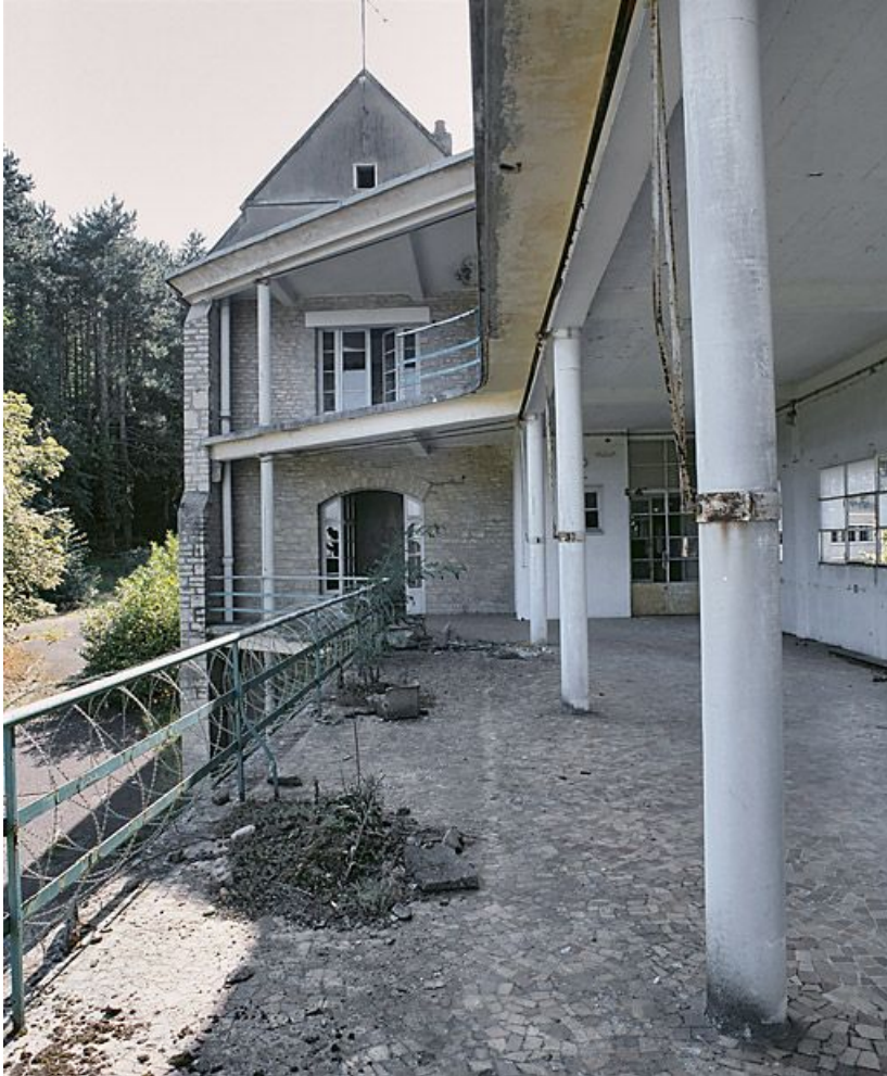
Galerie de cure est, façade sud-est.
