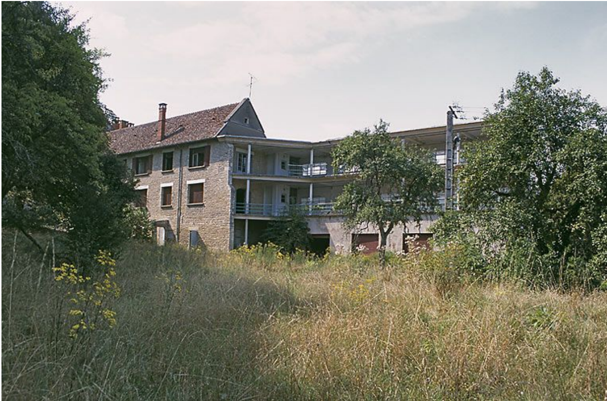
Galerie de cure est, façade sud-est.
