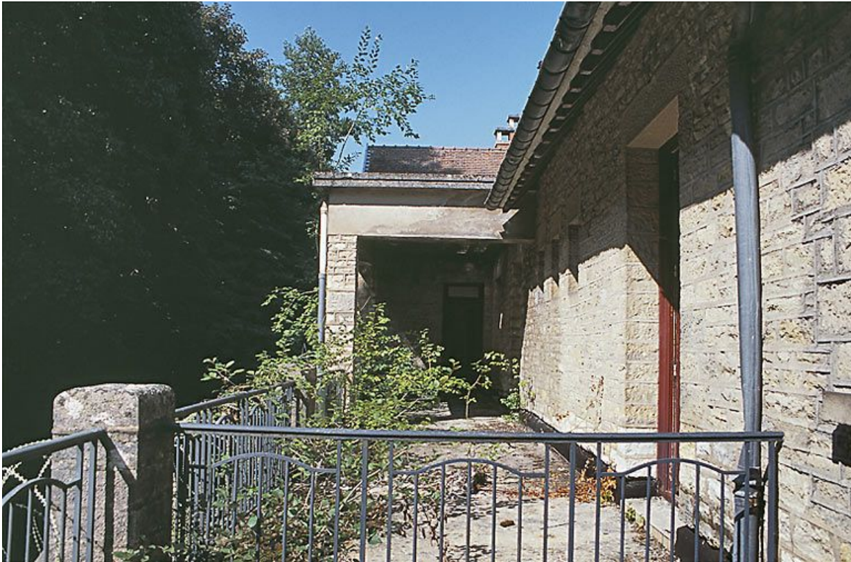
Bâtiment central, terrasses de la façade sud.
