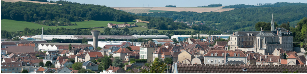
Vue panoramique. De gauche à droite : l'usine et la chapelle.
