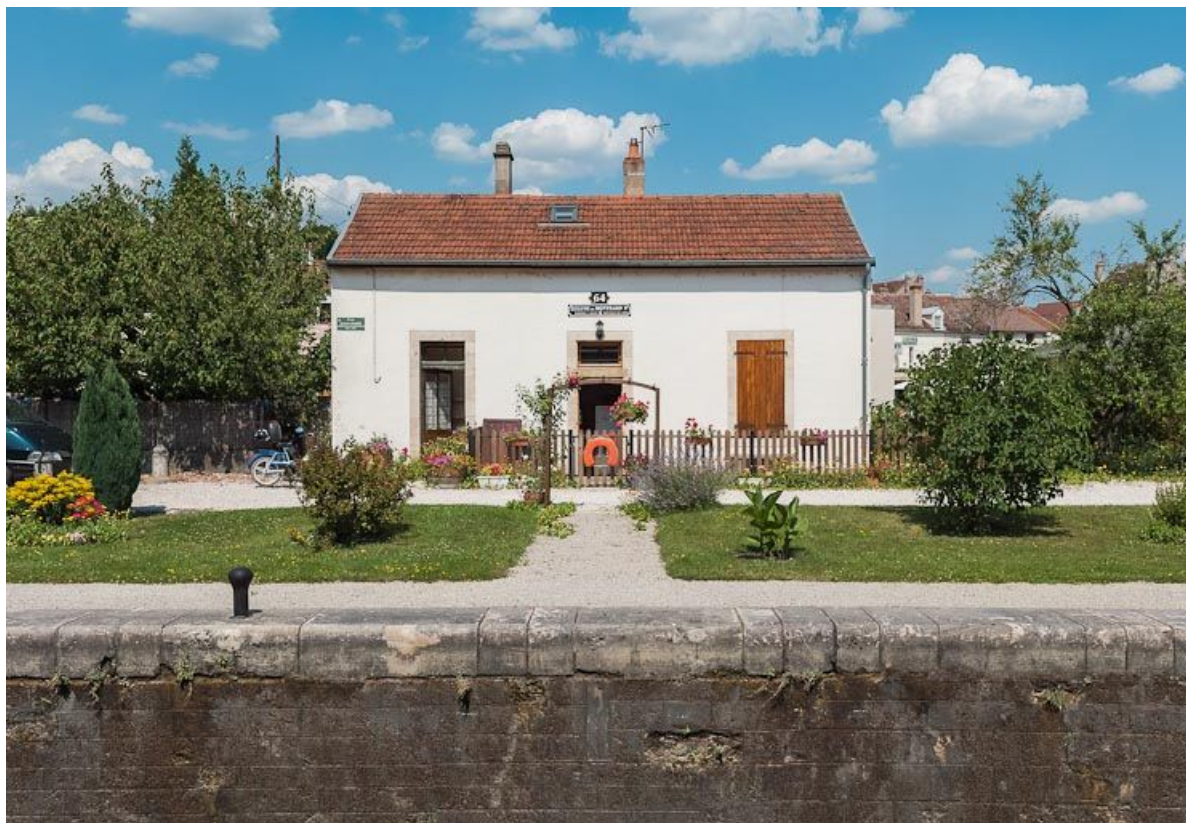
La maison éclusière vue de face.
