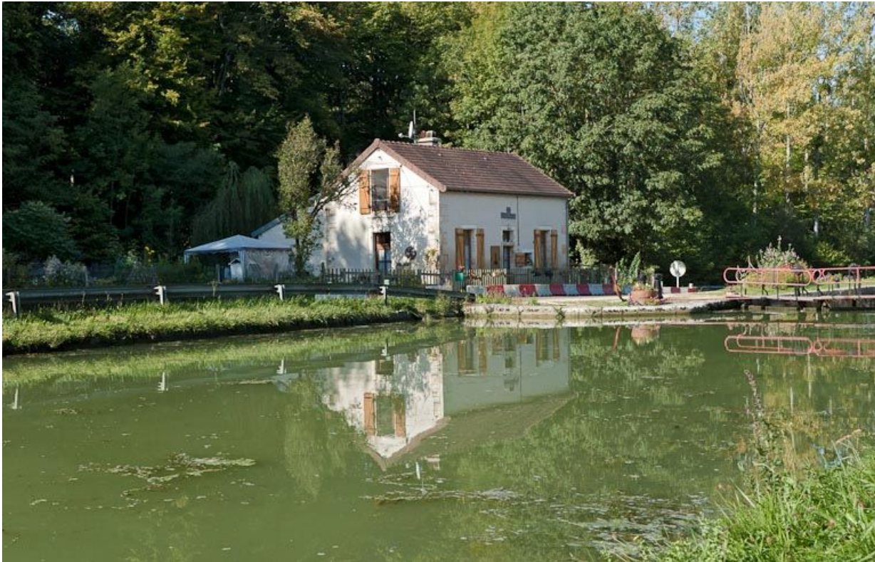
Vue du site d'écluse depuis l'amont.
