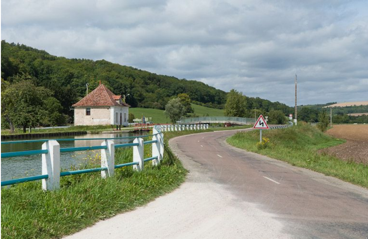
Vue du site d'écluse depuis la route.
