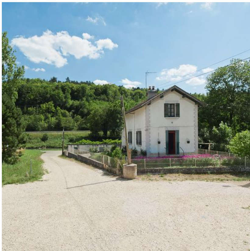
Vue de la maison de garde-barrière.
