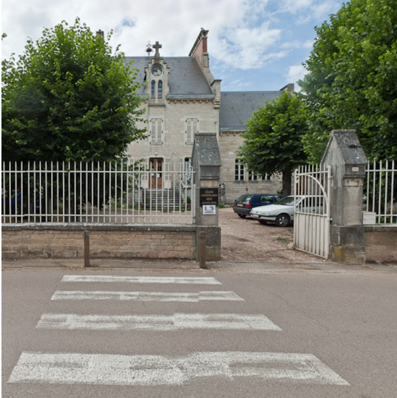
Vue du pensionnat depuis la route.
