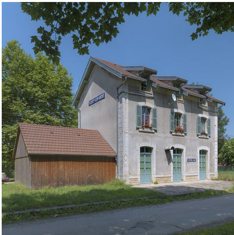
Le bâtiment des voyageurs, 3/4 gauche.
