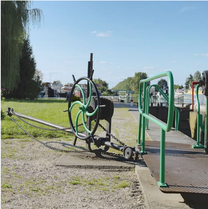
Détail du mécanisme des portes du sas.
