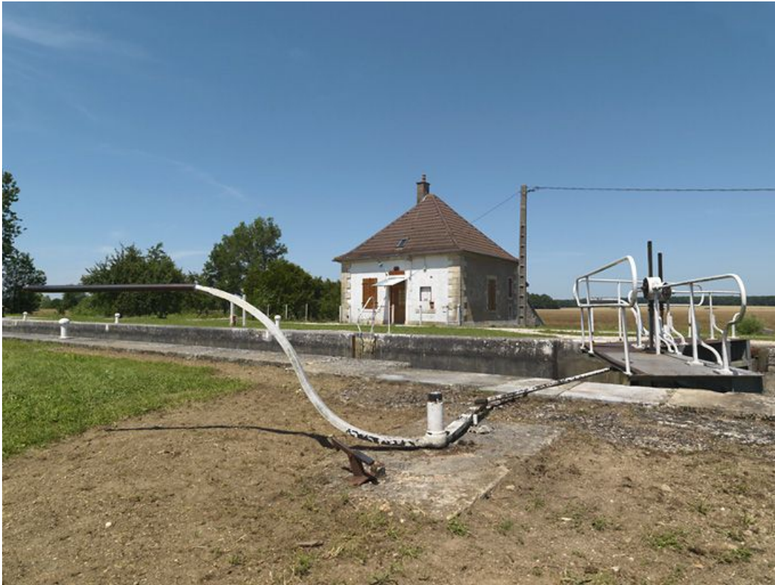
Vue d'ensemble de la maison éclésièr prise d'aval.
