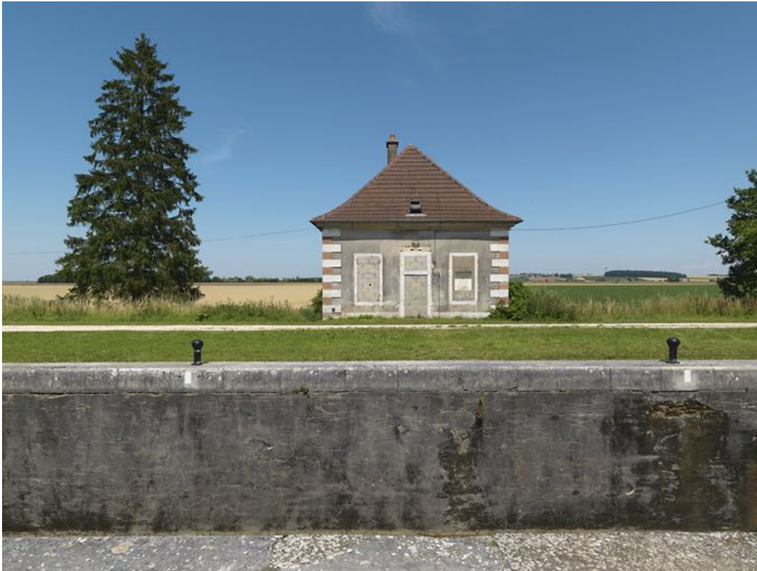
Maison éclusière : vue de face.
