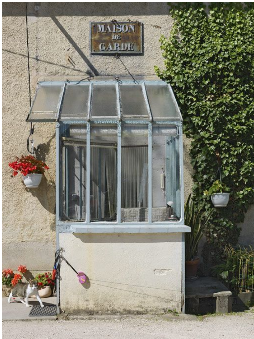
Détail : porte d'entrée et plaque.
