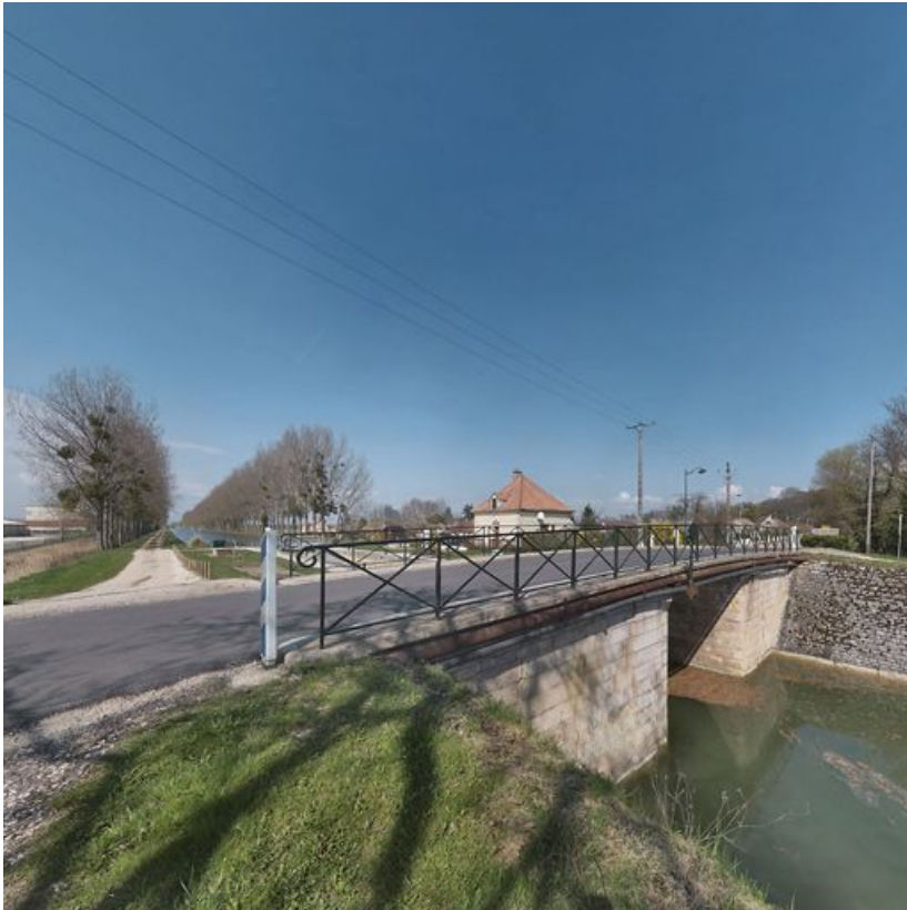
Vue d'ensemble, prise d'aval : remarquez le garde-corps.
