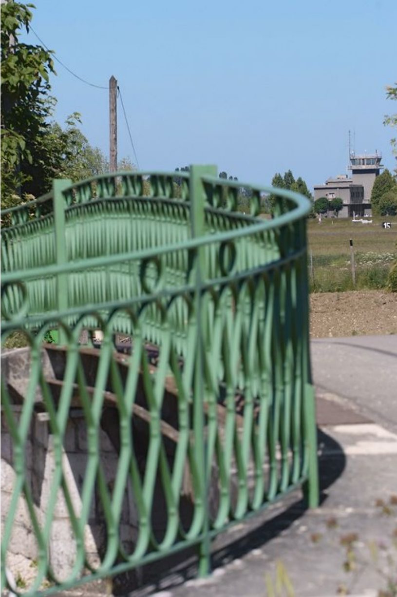
Détail du garde-corps en ferronnerie.
