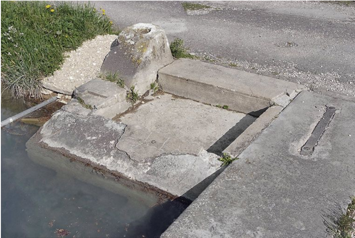
Lavoir maçonné à l'usage des éclusiers, placé avant la tête amont de l'écluse. 21, Dijon, lieudit : Larrey
