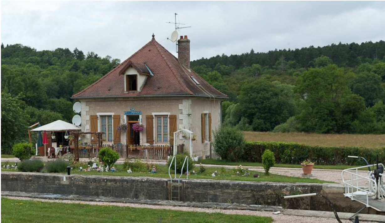
Vue de face de la maison éclusière.
