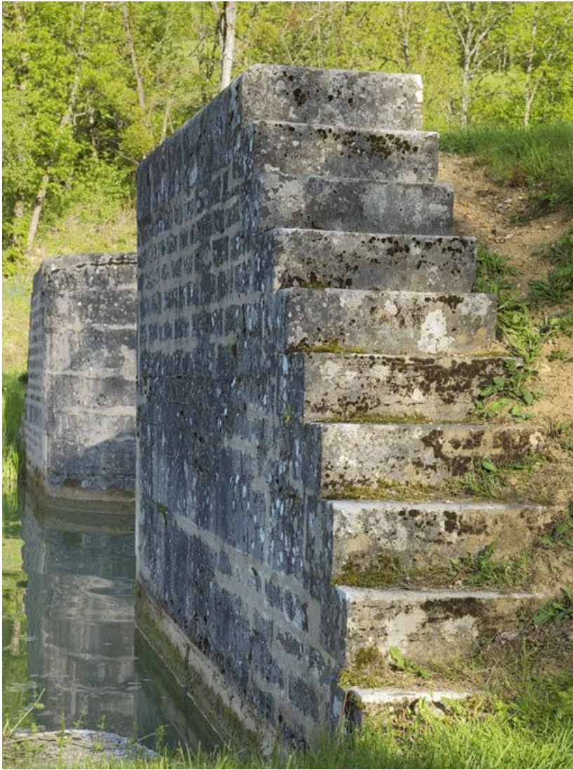
Tête aval du sas : l'escalier.
