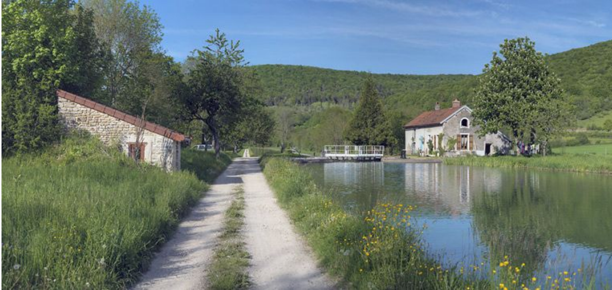
Vue d'ensemble de l'amont de la maison éclusière. 21, Veuvey-sur-Ouche, lieudit : bief 24 du versant Saône
